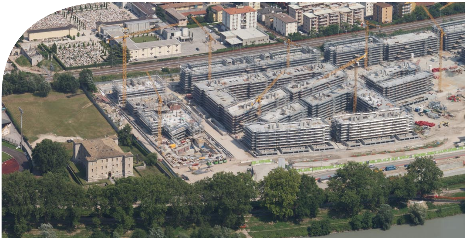
In copertina e sopra: Riqualificazione ex area Michelin, Trento - Cliente: Trento Futura S.c.a.r.l.
