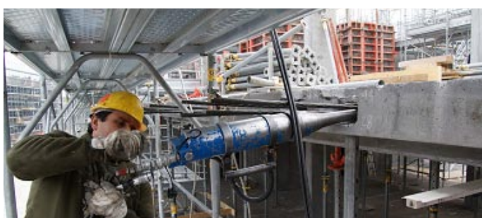
Tesatura dei cavi con martinetto monotrefolo
