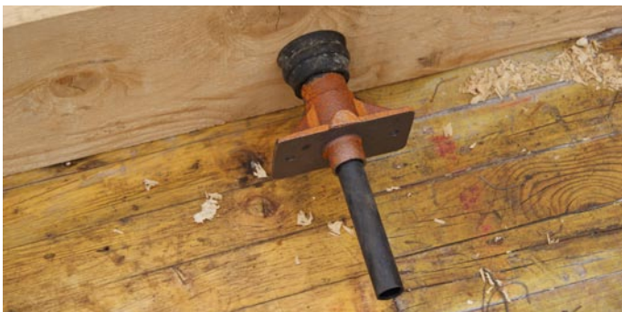
Esempi di ancoraggi monotrefolo fissati al cassero
