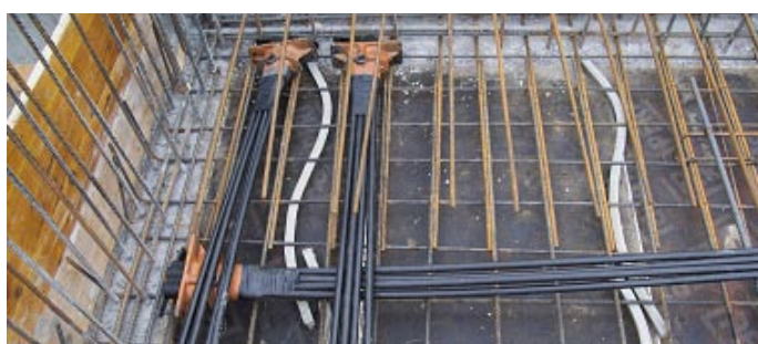
Ancoraggi fissi preconfezionati e inseriti in soletta prima del getto
