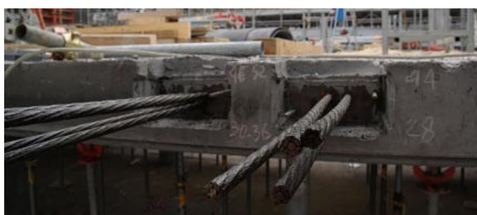
Scassero soletta con cavi pronti per la tesatura
