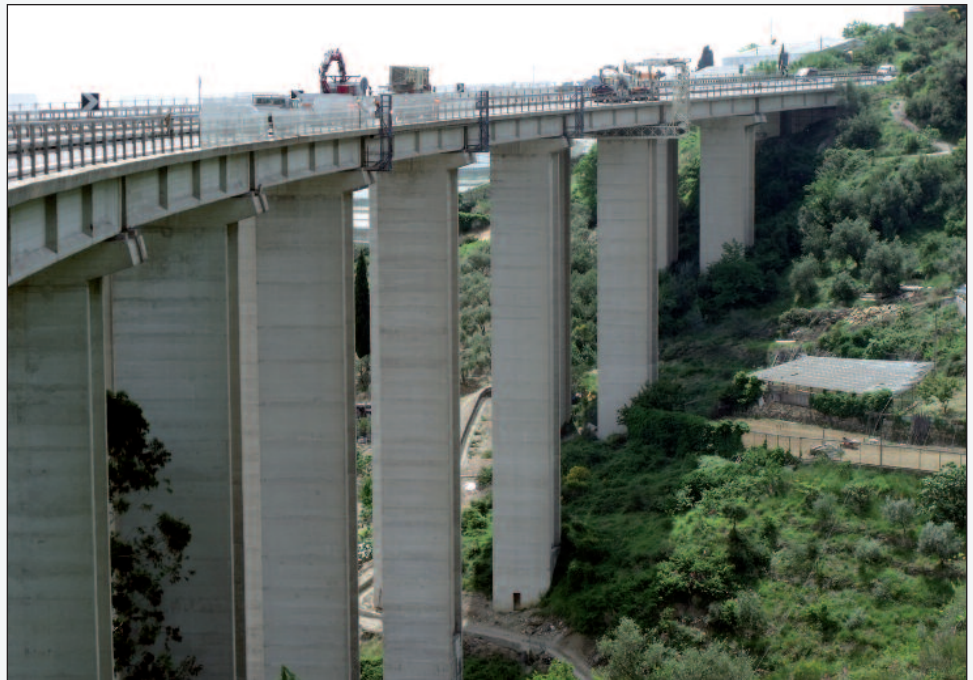
Figura 1 - L'intervento di adeguamento sismico sul viadotto Rio Gozzo
