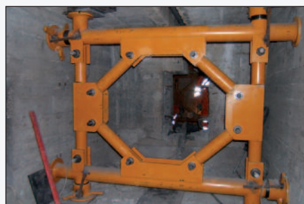
Figura 11 - Le carpenterie metalliche temporanee
