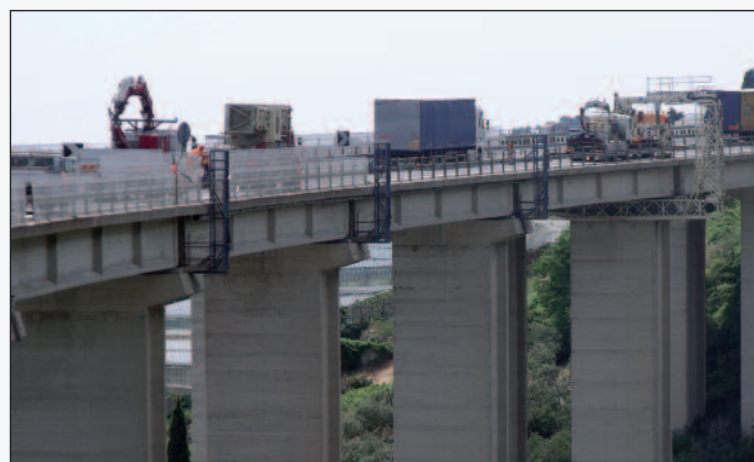
Figura 4 - Le squadre della Alga in azione sul viadotto Rio Gozzo
