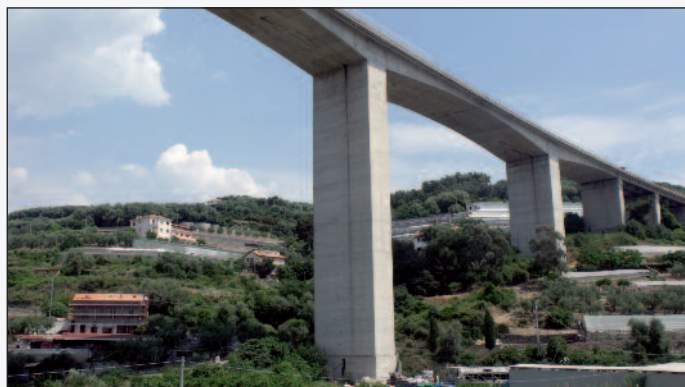
Figura 9 - Il viadotto San Lorenzo
