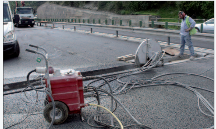
Figura 8 - Il taglio della soletta mediante disco diamantato
