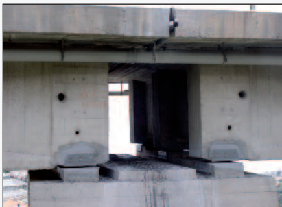
Figura 7 - La testa della pila e gli appoggi antisismici dopo l'adeguamento
