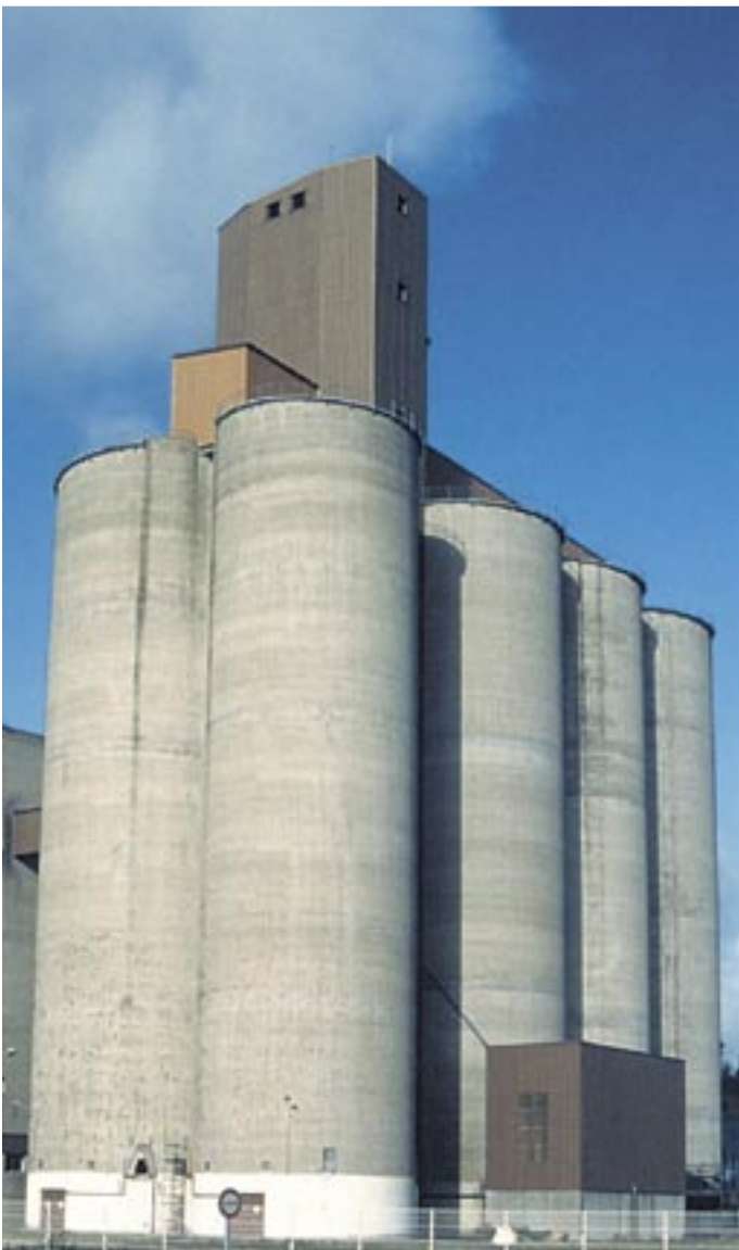
Impianto industriale: ripristino del calcestruzzo attraverso rimodellazione e successivo trattamento idrorepellente.
