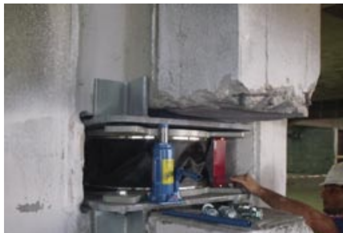
L'Aquila, Tribunale. Adeguamento sismico mediante taglio dei pilastri e successivo inserimento alla base di isolatori a pendolo scorrevole Algasism APS.
