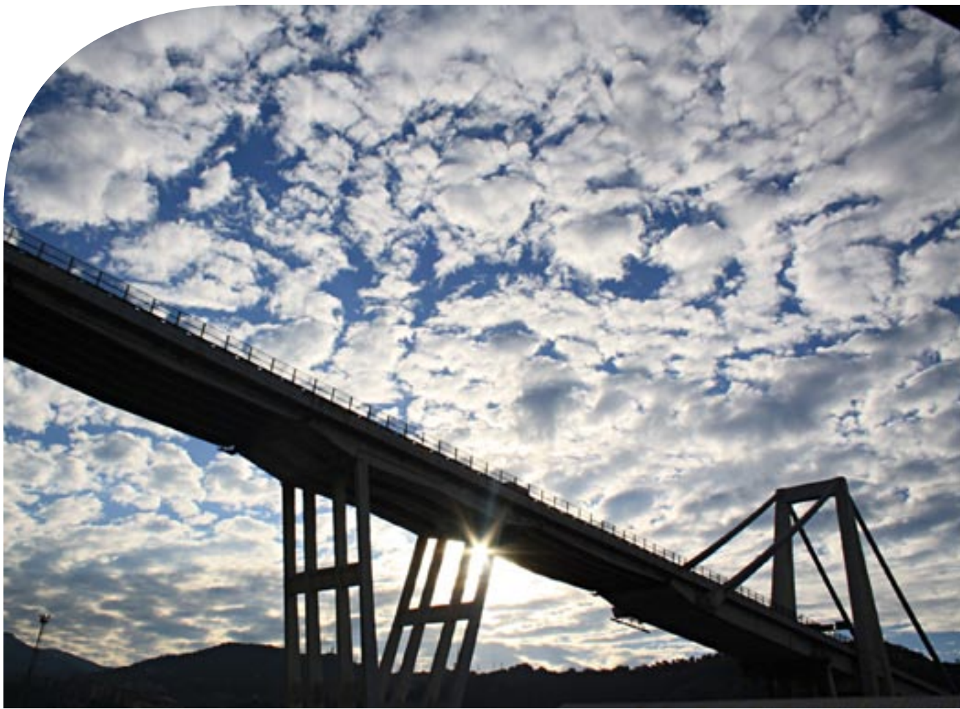
Autostrada Genova-Savona, Viadotto Polcevera Ripristino delle zone ammalorate dei tiranti e installazione di stralli Alga AL200 con relative carpenterie di collegamento alla struttura esistente.
