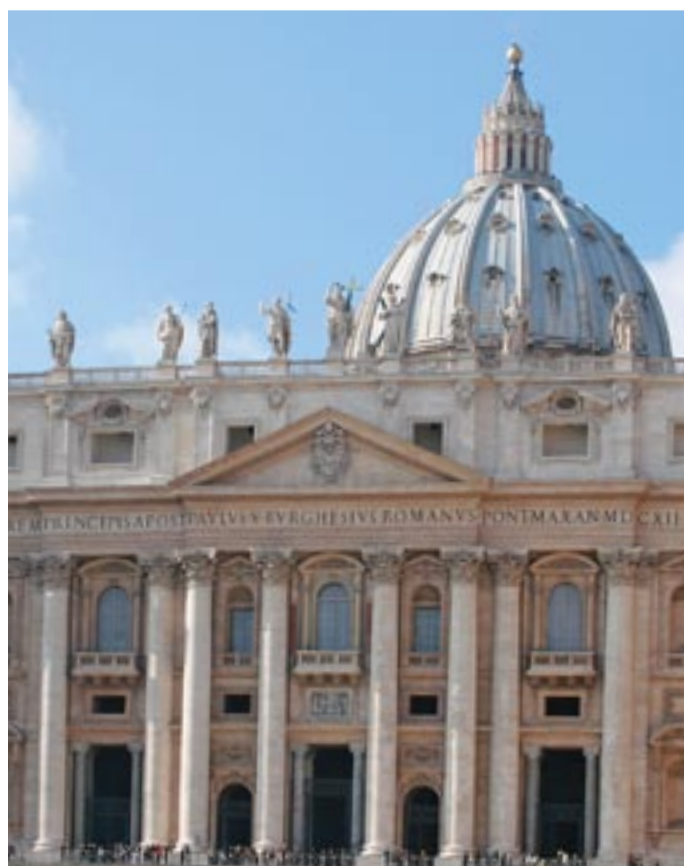
Roma, Basilica di San Pietro Rinforzo e collegamento alla struttura della facciata attraverso l'inserimento e la tesatura di dodici catene cinematiche.
