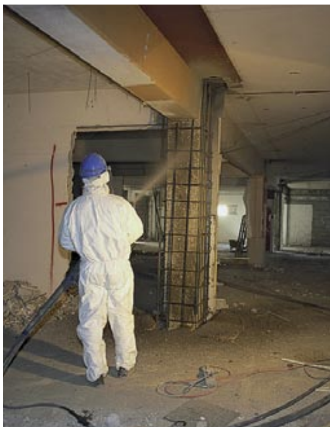
Rinforzo del calcestruzzo dei pilastri con rimodellazione a spruzzo.
