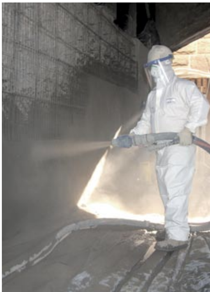
Rinforzo del calcestruzzo di pile con rimodellazione a spruzzo
