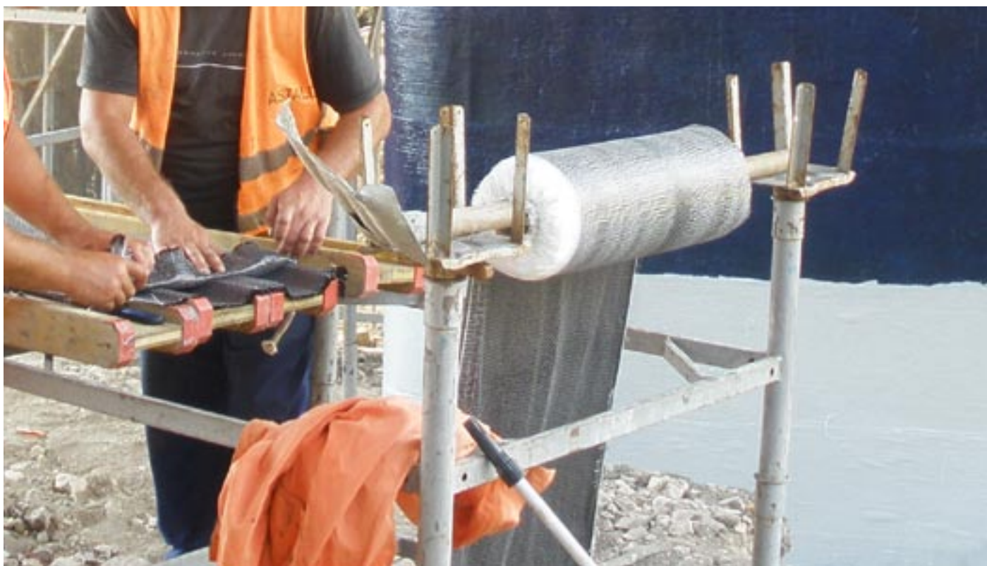
Pavlov (Bulgaria), tratta ad Alta Velocità Sofia – Istanbul: adeguamento sismico di pile da ponte mediante impiego di tessuti in FRP.
