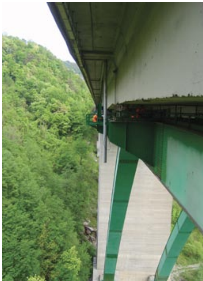
Autocamionale della Cisa, Viadotto Gravagna. Spessoramento degli appoggi elastici con elementi calibrati per l'adeguamento delle coazioni rilevate nel viadotto a quelle di progetto.
