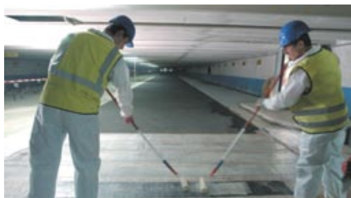
Consolidamento di solaio mediante incollaggio di tessuti in FRP ad alto modulo elastico.
