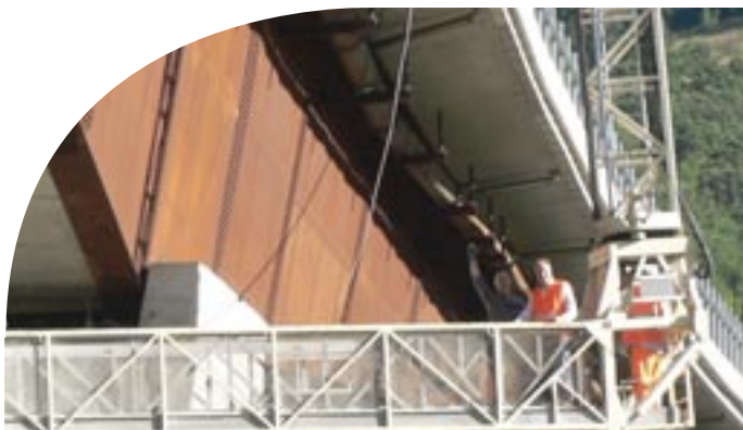
Autocamionabile della Cisa, Viadotto Roccaprebalza. Sollevamento del viadotto e sostituzione dei dispositivi antifrizione.
