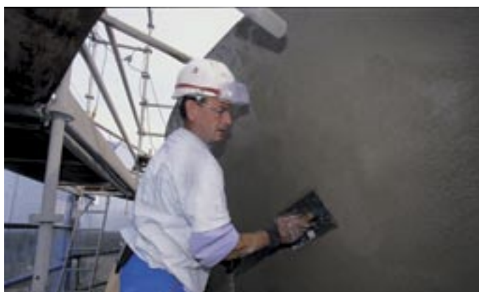
Riparazione localizzata e rimodellazione del calcestruzzo.
